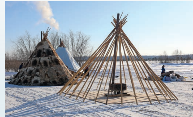
Tchoum en construction dévoilant sa structure
